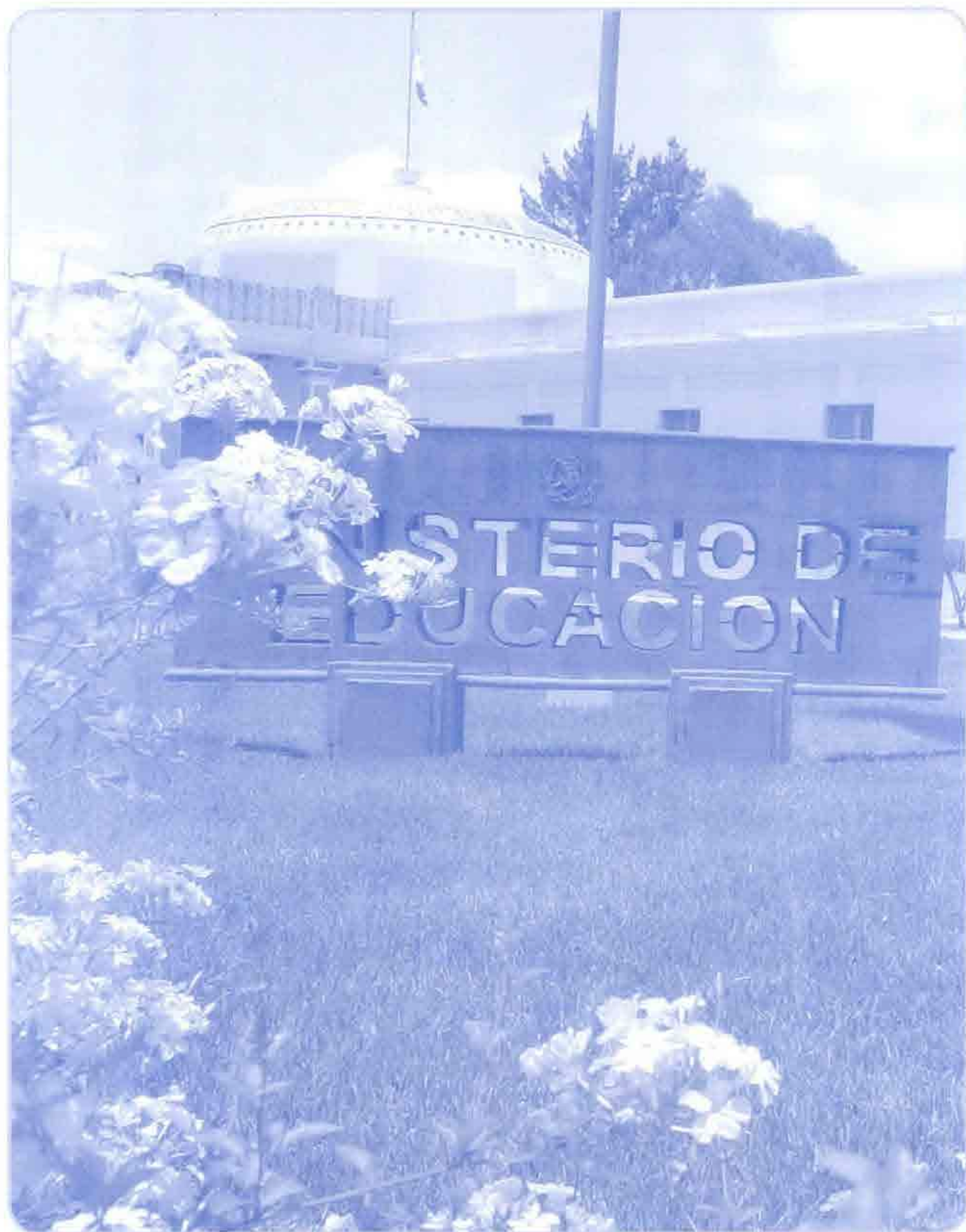
Edificio del Ministerio de Educación, 6a. calle 1-87 zona 10
